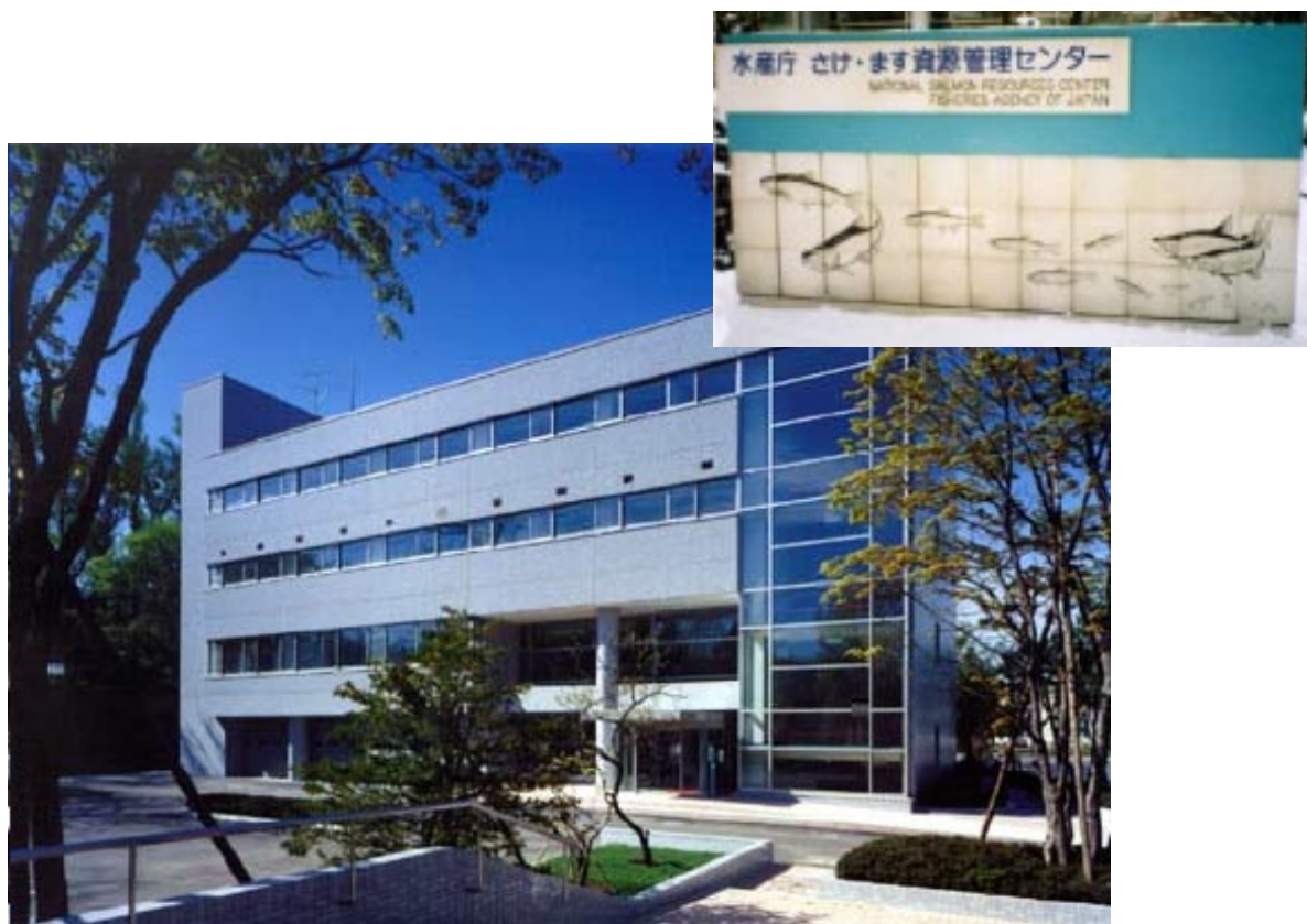
さけ・ます資源管理センター本所庁舎と新名称を記した庁名板
