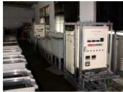
図1. 片岸川ふ化場に設置した耳石温度標識装置
