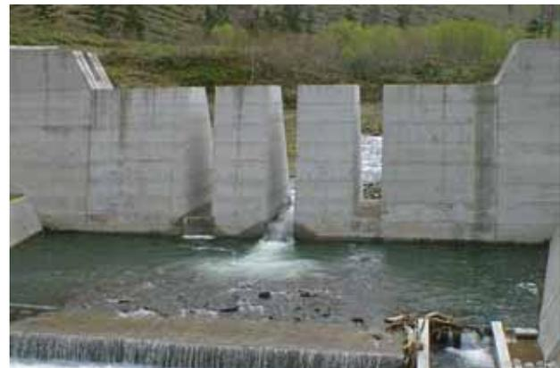
上．魚道のない砂防ダムでジャンプを繰り返すサクラマス親魚（天塩川の一支流）．左下．階段状に延々と続く砂防ダム群．右下．最近あちこちに作られ始めたスリット式砂防ダム．洪水時に一気に土砂の流れるのを防ぐ機能を備えながら，平水時には下流に土砂を供給し，さらに魚類などの通路を確保する．通路を塞ぐ流木や巨石が流下してきたときの管理が今後の課題となる（尻別川支流目名川）．これら魚道とさけ・ます類の関係については本文1-7頁を参照ください．
