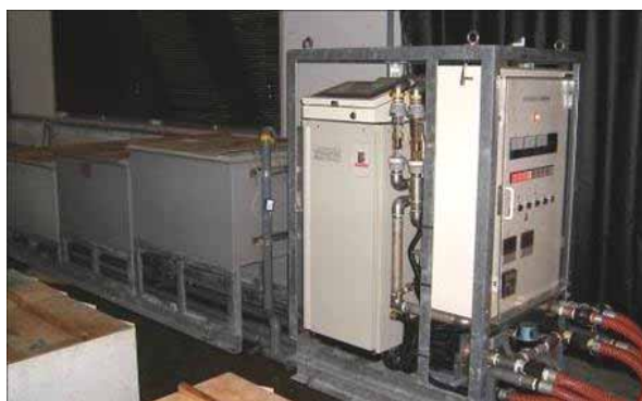
図4. 片岸川ふ化場に設置している耳石温度標識装置。ふ化槽に流れるふ化用水温を定期的に上下させることによって、槽内に収容している発眼卵の耳石に標識となる輪紋が形成される。
