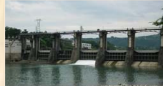
↑発電用の大型ダム
