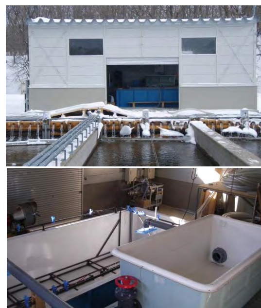
図 3. フィッシュポンプと大型水槽等を組み込んだ作業施設。
