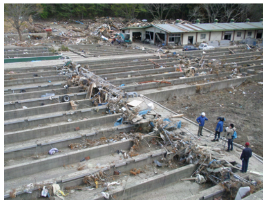
写真2. 岩手県宮古市の津軽石ふ化場。平成23年5月10日、第1次現地実態調査で撮影。
