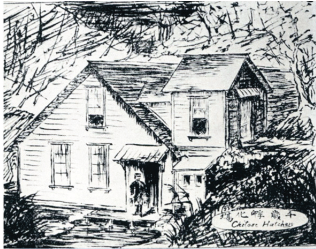
明治 21 年に建設された千歳鮭鱒人工孵化場「甲号孵化室」
