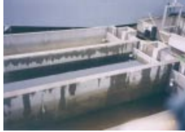
写真4. ガスティノふ化場の陸上池。立体的孵化槽から集められた浮上稚魚はこの屋外池に集められ、その後、海面の生簀に移される。この池は写真2の魚道と繋がっており、親魚の捕獲施設としても使用される。
