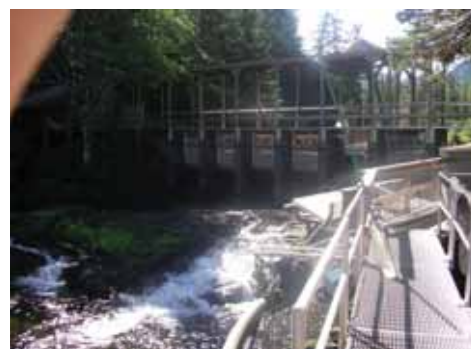
写真4. サシン川河口の梁。
